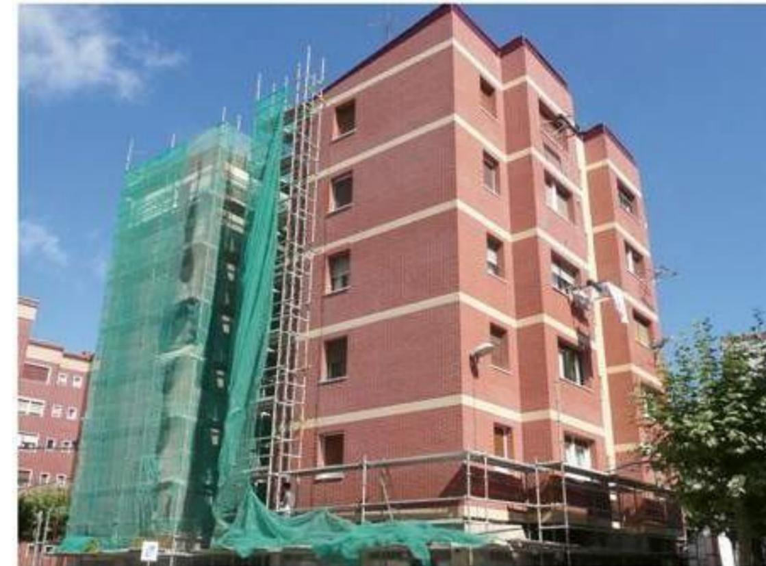
Candi Wall mejora o modifica el aspecto externo del edificio. Teniendo en cuenta la importancia del ahorro energético, "CANDI WALL SYSTEM" es un excelente aislamiento térmico, junto a un acabado de ladrillo caravista cerámico de alta durabilidad y nulo mantenimiento.
